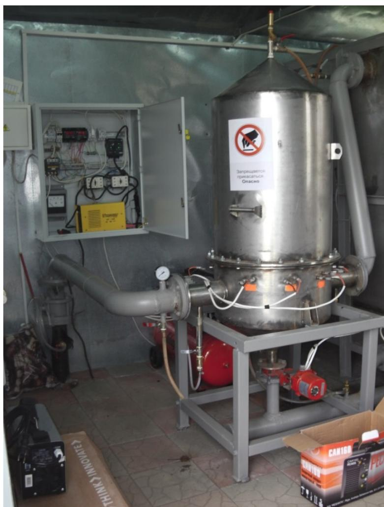
*Рис. 24. Установка комплексной очистки артезианских вод электрохимическим методом*
