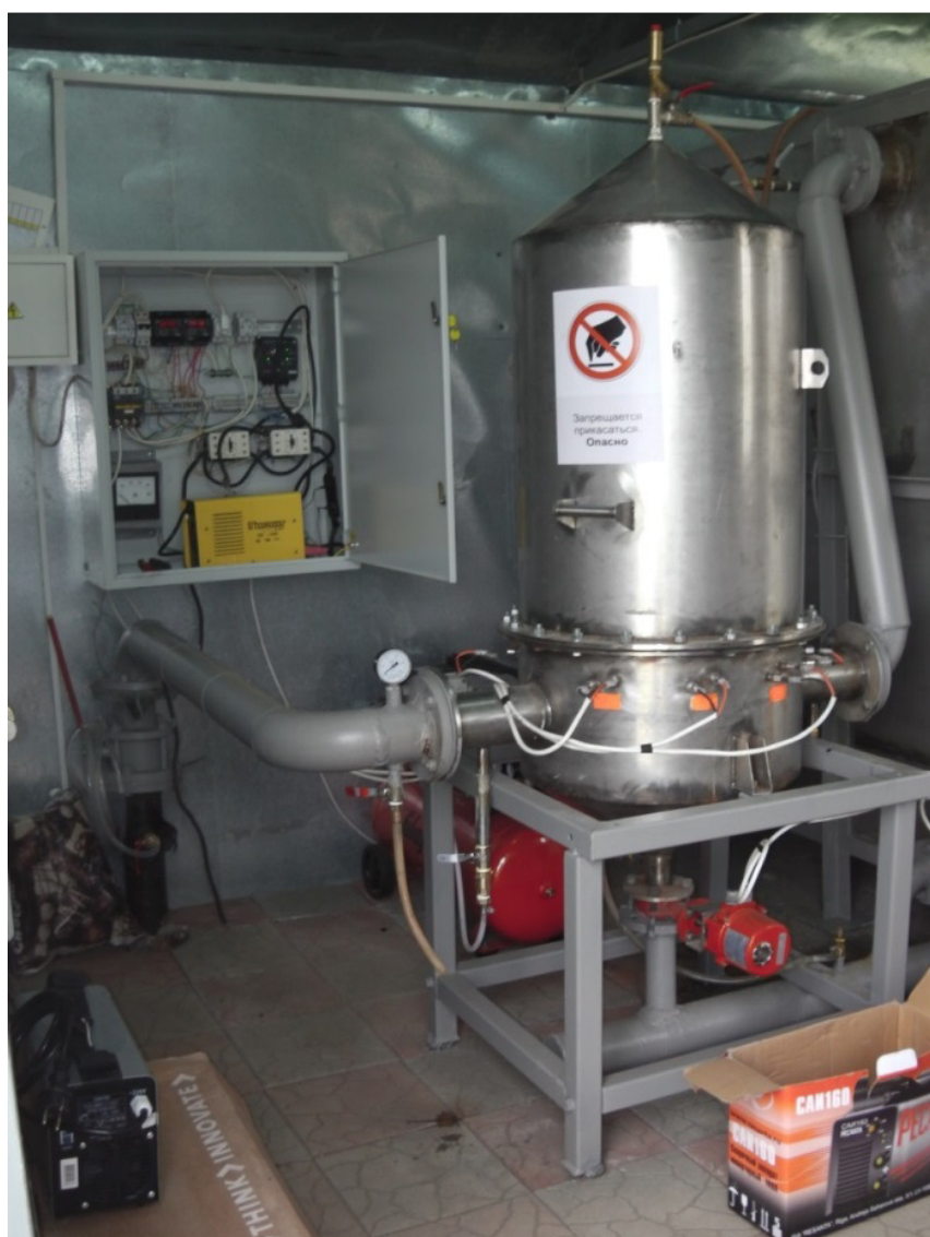
Рис. 24. Установка комплексной очистки артезианских вод электрохимическим методом
