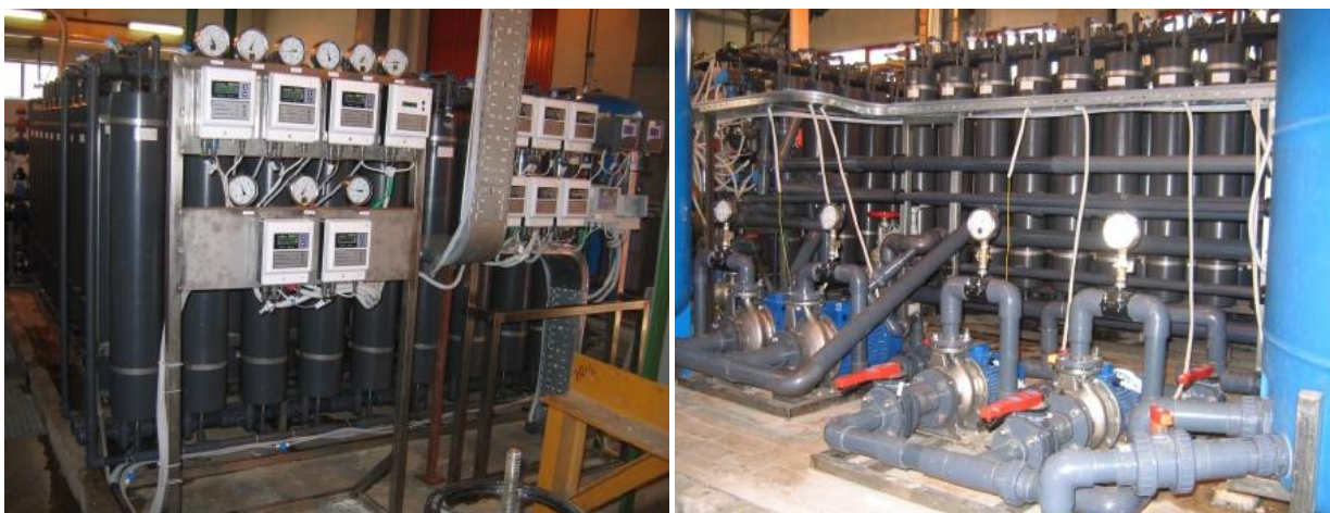
Рис.45. Модули очистки микрофльтрационной установки.
