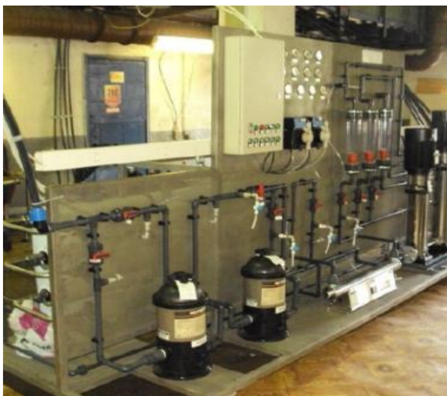
Рис.52. Микрофльтрационный блок автономной опреснительной установки.
