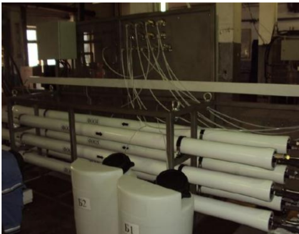
Рис.53. Обратноосмотический блок автономной опреснительной установки.
