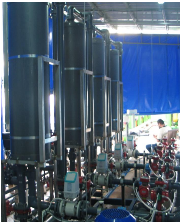
Рис.42. Общий вид микрофильтрационной установки УМФ - 177.
