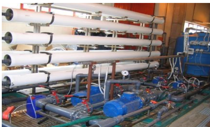
Рис.46. Система обратного осмоса.
