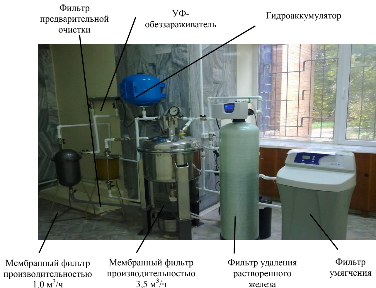
Рисунок 46 – Фотография установки доочистки питьевой воды.
