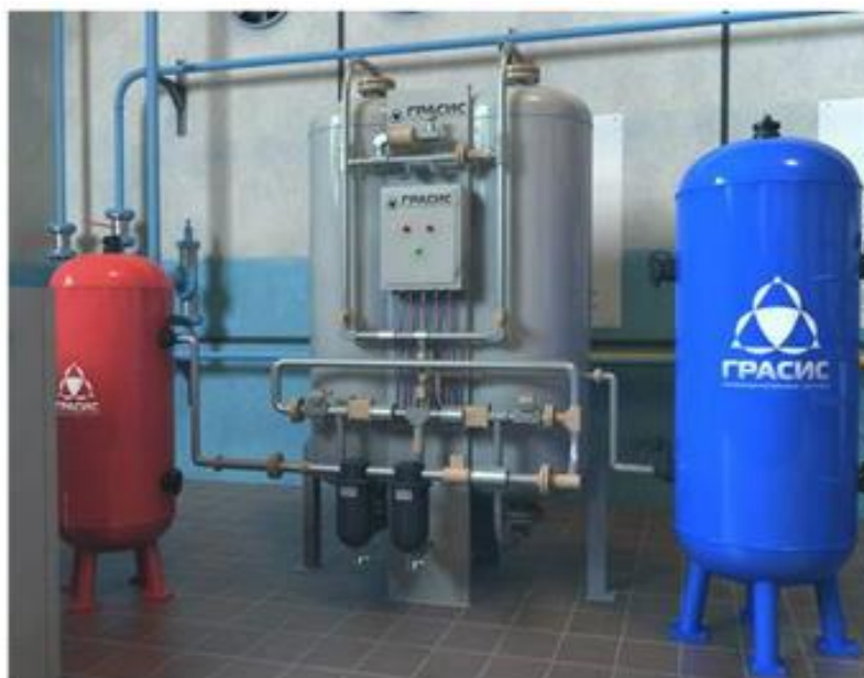
Рис. 1.13. Адсорбционная кислородная установка компании «Грасис»
