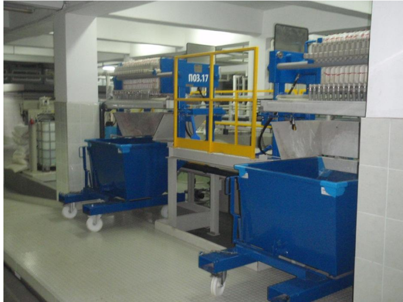
Рисунок 3.21. Вид станции нейтрализации сточных вод (фильтр-прессы).
