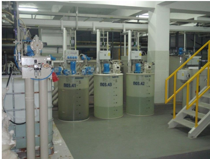
Рисунок 3.19. Вид станции нейтрализации сточных вод (блок дозирования химикатов).
