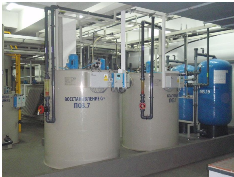
Рисунок 3.20. Вид станции нейтрализации сточных вод. Реакторы нейтрализации
