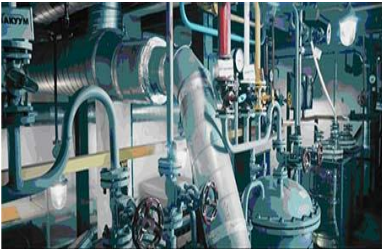
Рис. 1.2 Технологическое оборудование на производственном комплексе АО «ЭКОС-1»
