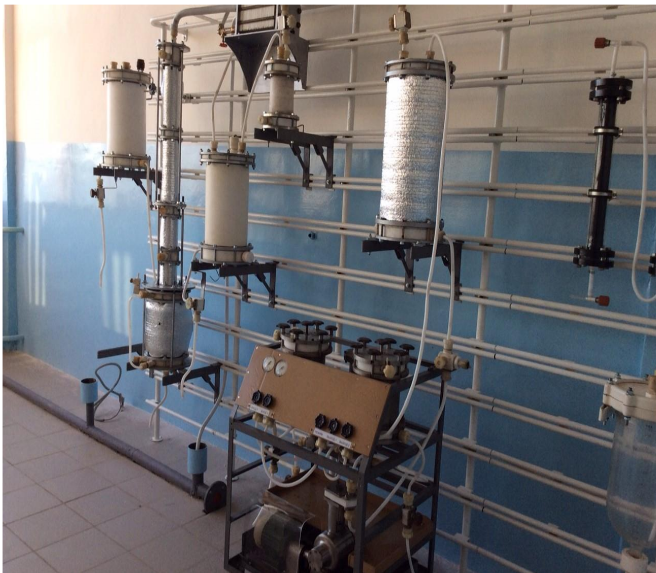
Рис. 3.6 Исследовательский модуль ректификационной очистки выполненный из фторопласта-4 и установленный на экспериментальном участке АО «ЭКОС-1»
