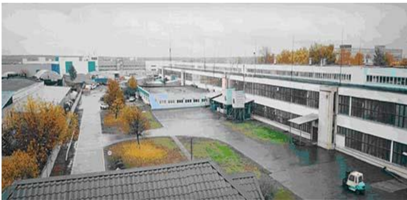
Рис. 1.1 Производственный комплекс АО «ЭКОС-1» (Старая Купавна, Московская область)
