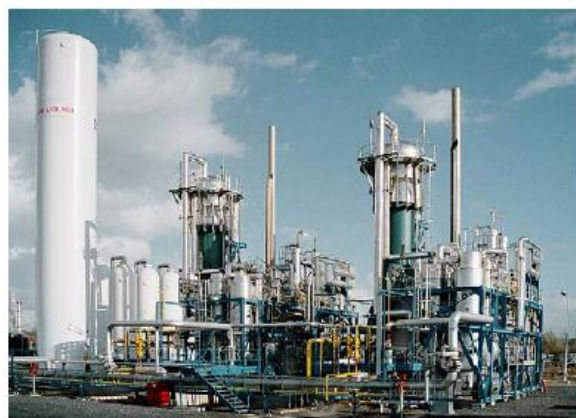
Рисунок 16. Технологическая схема завода по получению 2 x 5000 н.м 3 /ч H 2 на базе HTCR. Topsoe at Air Liquid, Belgium. [88]
