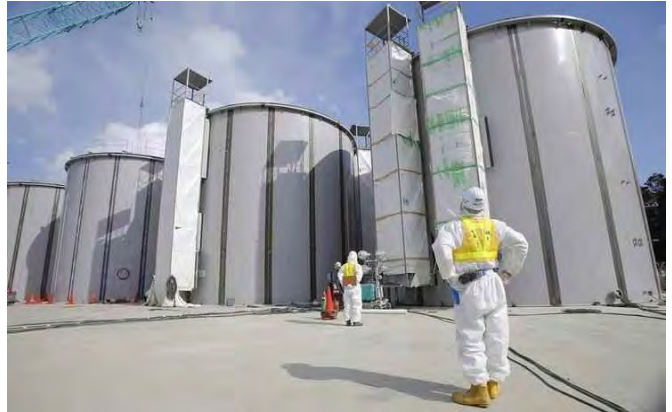
Рис. 1.6. Хранилища тритийсодержащей воды на АЭС «Фукусима-1»: а - аэроснимок: Asahi Shimbun [67], б – вид резервуаров [68]
