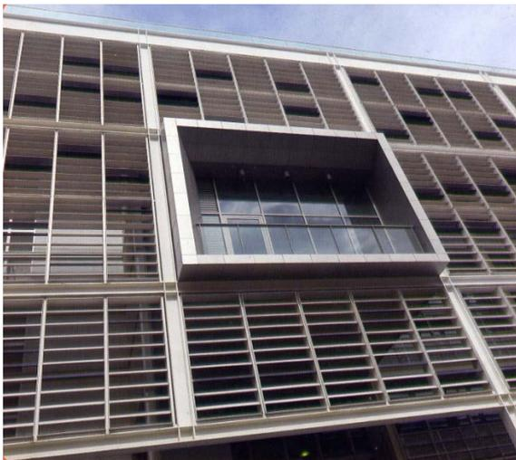
Рисунок 1.7 – Офисное здание с использованием биоклиматического фасада из подвижных керамических плиток. Валенсия [72]
